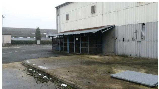
Cuve enterrée de fioul 50 m 3 (inertée à l'eau)
