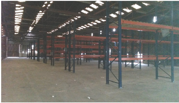
Racks dans le Hall 8
